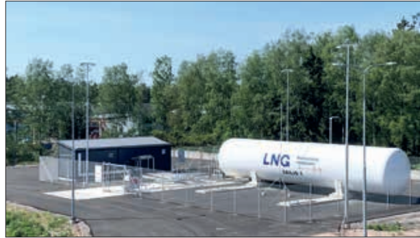
Säköylän tehtaalla uusi nesteytetyn maakaasun varastointi- ja höyrystyslaitos.
